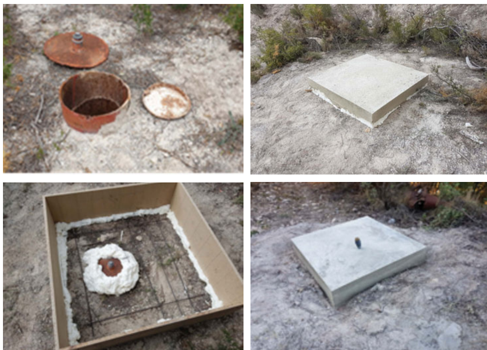
Figura 3.4. Fases de clausurado de un sondeo dejándolo cerrado totalmente o preparado como piezómetro.
