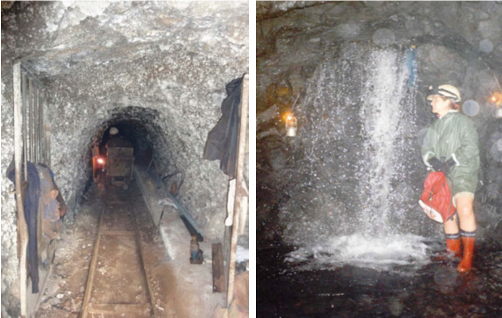
Figura 2.7. Galerías mineras en la Isla de Tenerife, con un frente brotando agua.
