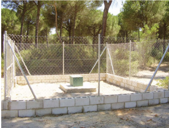
Protección del sondeo, con arqueta o dado de cemento y valla protectora.
