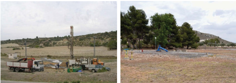
Figura 3.3. Equipos de construcción de un sondeo e instalaciones de captación de agua subterránea para abastecimiento.
