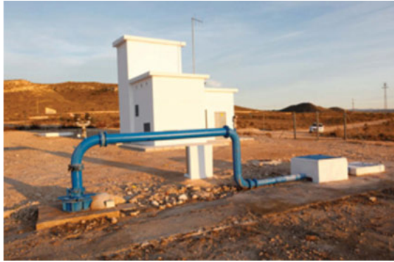
Pozo de abastecimiento, con equipamiento e infraestructura modélica.
