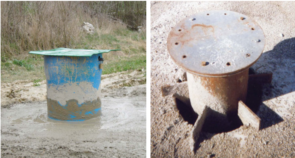
Figura 4.5. Cierre provisionalmente del sondeo con placa soldada y sondeo preparado para colocar el dado de cemento en el emboquille.
