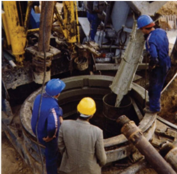
Figura 4.7. Vertido de hormigón por gravedad al interior de un pozo.
