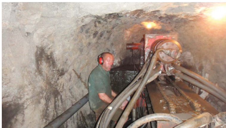
Trabajando en el interior de una galería para captar aguas subterráneas.
