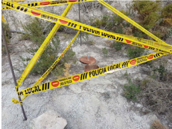
Protección del sondeo mientras se realiza la labor de sellado.
