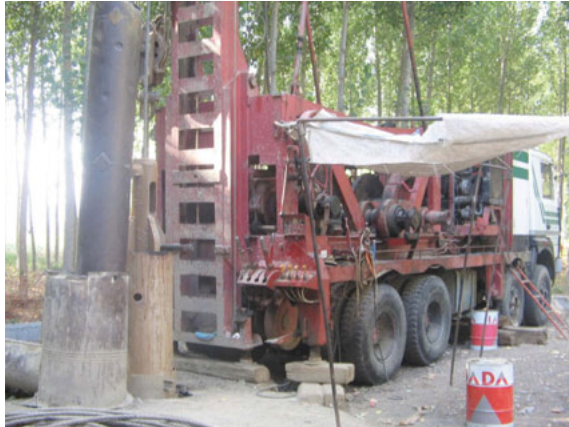
Máquina de percusión limpiando de detritus el sondeo con la válvula o cuchara.
