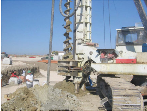
Máquina de perforación minera trabajando con sistema de hélice.
