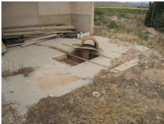
Sondeo abandonado sin cumplir ninguna de las normas de seguridad, siendo un riesgo para las personas y el medioambiente.
