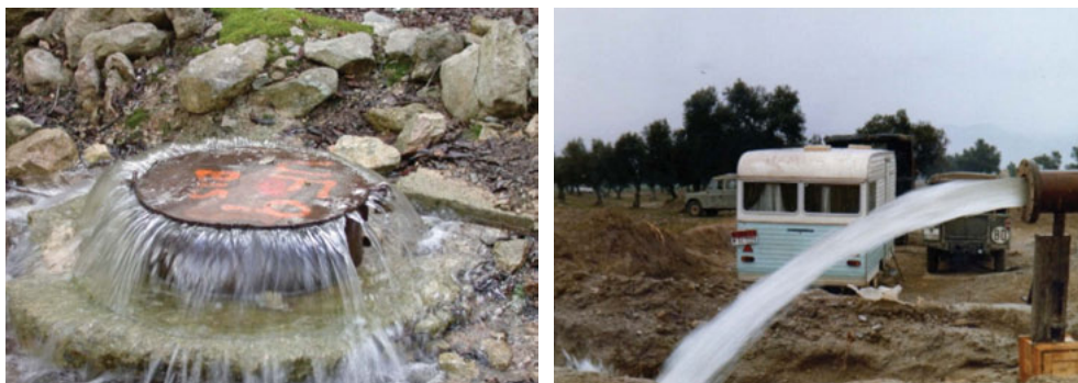
Figura 3.1. Pozo surgente, a la derecha aforo y ensayo de bombeo de aguas subterráneas.
