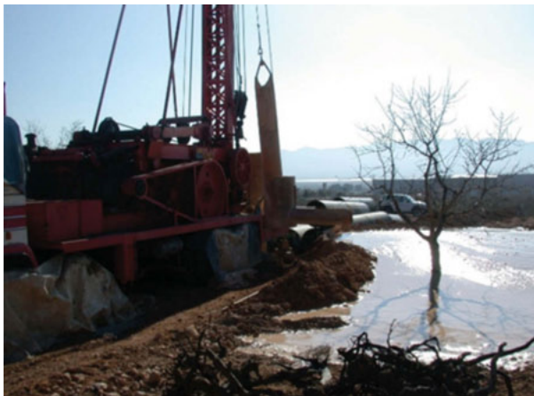
Figura 3.5. Máquina de perforación mediante el sistema de percusión, y extracción del detritus con cuchara.
