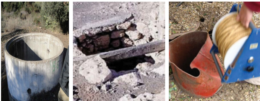
Figura 4.6. Ejemplos de pozos y sondeos abandonados, con un gran riesgo para las personas.
