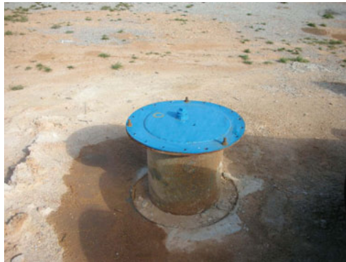
Cierre provisional hasta acondicionar.
