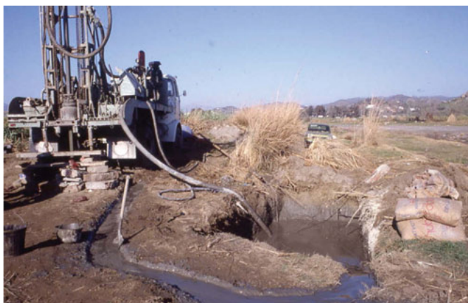
Máquina de perforación a circulación directa con balsa de lodos.
